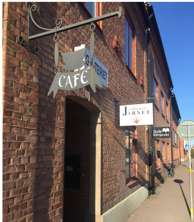
Café Gjutariets fasadskylt är smidd av konstmed Örjan Holm som tidigare hade sin ässja i Gjutariets gamla pannrum.
